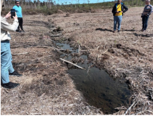
Imaxe 8 – Detalle da canalización de auga na parcela forestal
